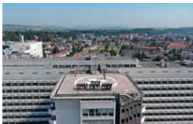
Die Einsatzinheit auf dem Dach des Übungsobjektes
